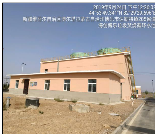
循环冷却水塔
